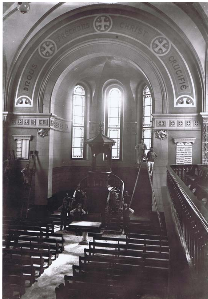
Photo Hector Reymond. Les dernières finitions de l'intérieur.
